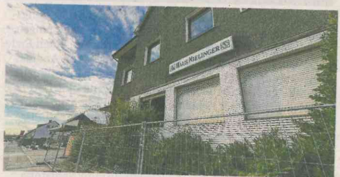
Auf der Fläche vom Haus Nielinger (Archivfoto) soll eine neue Sparkassen-Filiale entstehen. Die Gaststätte ist mittlerweile abgerissen.
