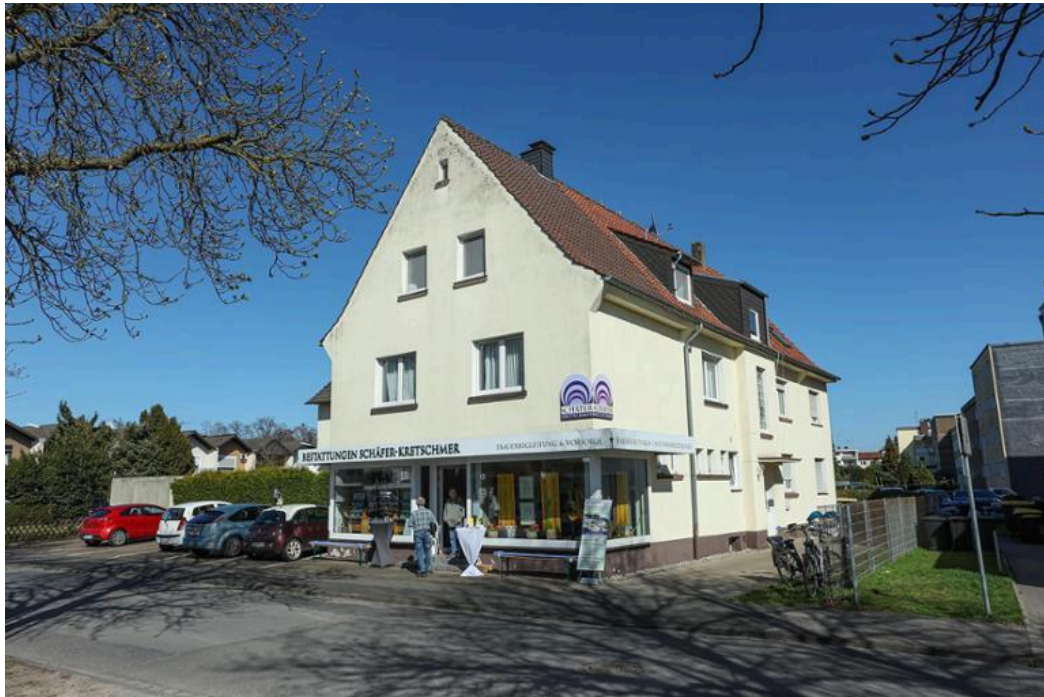
An den Schaufenstern ist die gemeinsame Nutzung gut zu erkennen. © Jörg Prochnow
