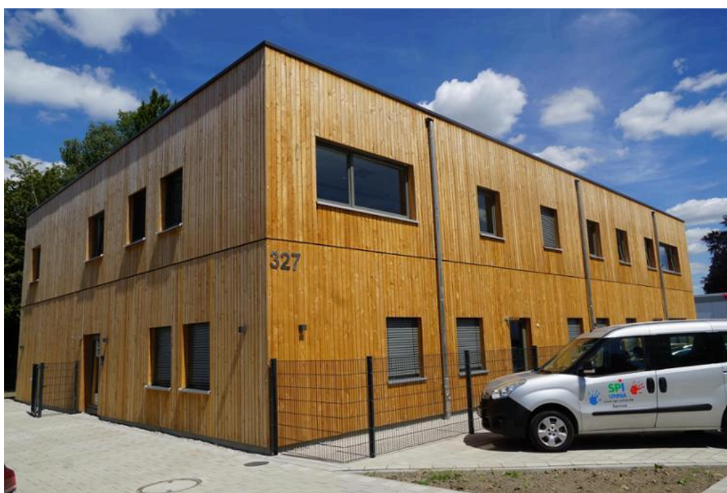
Nach weniger als einem Jahr Bauzeit kann die Spielbande jetzt in den Neubau an der Bahnhofstraße ziehen. © Sabine Pinger
